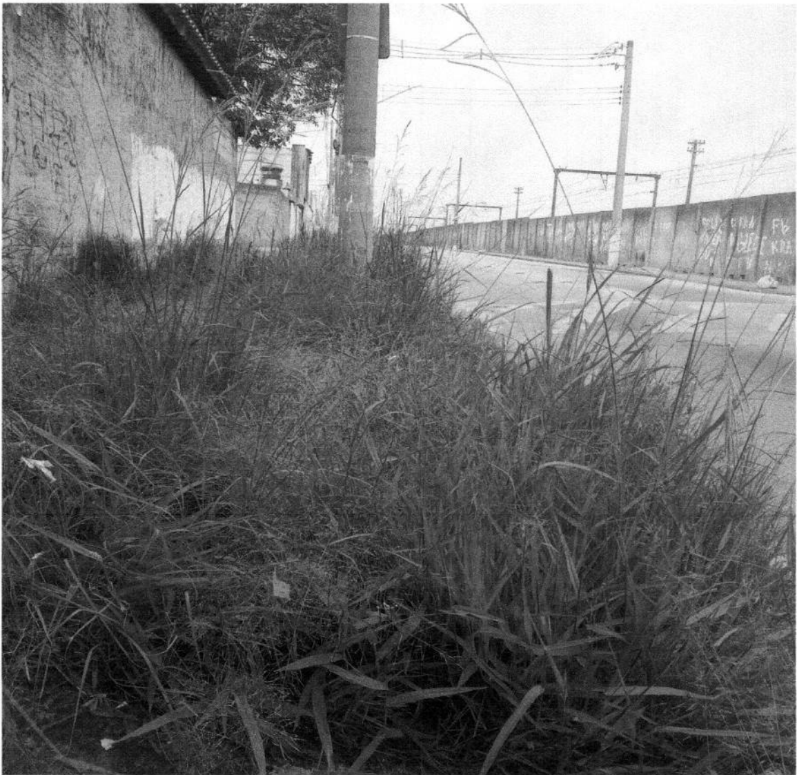
CAPINAÇÃO DE CABEÇAS DE GUIAS E RASPAGEM DE SARJETAS em toda extensão da Av. Anchieta, Vila Jundiá – Mogi das Cruzes.
